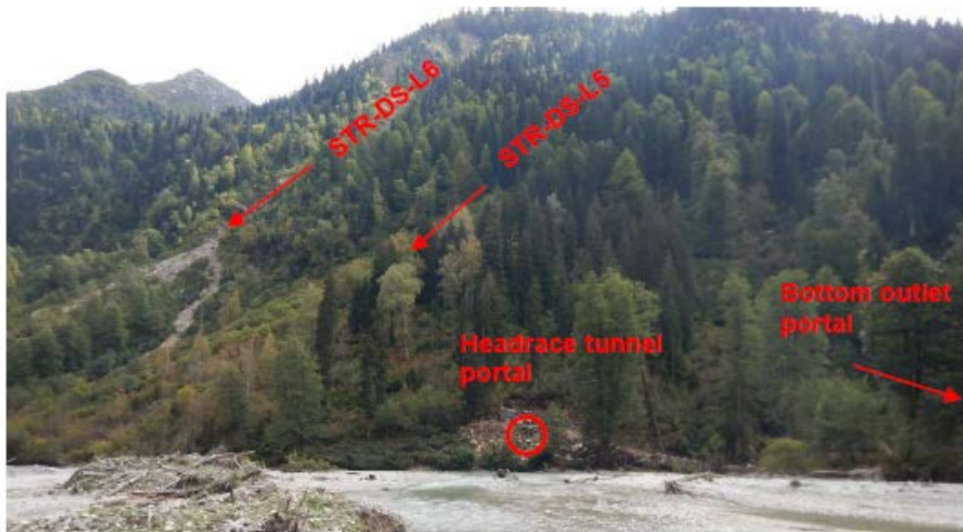
ნახაზი 17: მიმყვანი გვირაბის და ფსკერული წყალგამშვების შესასვლელი პორტალები (სურათიდან ოდნავ გარეთ) მდებარეობს ფერდობის ძირში
