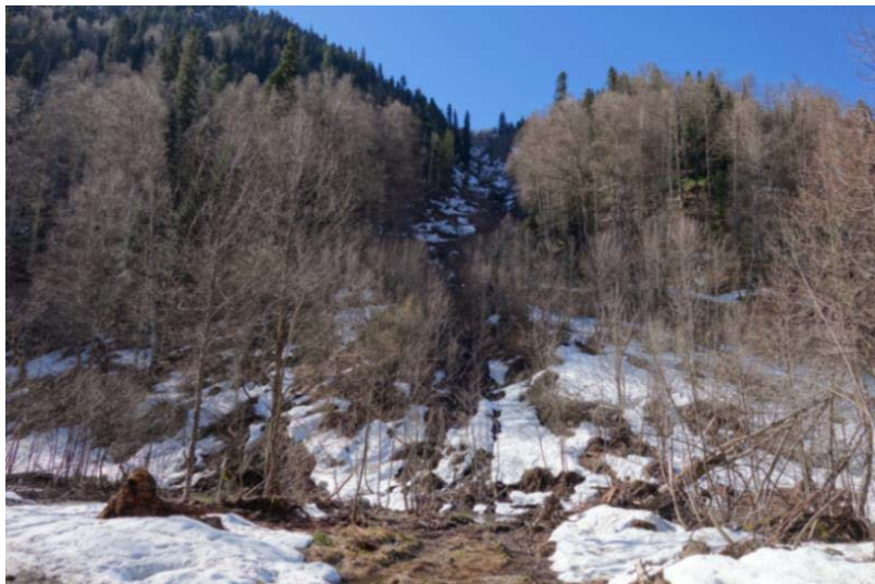
ნახაზი 12: ხედი ხეობის ფსკერიდან წყალსაგდების წყალმიმღების მიმართულებით, რომელიც მდებარეობს STR-DS-L4 არხის ზედა ნაწილში.
