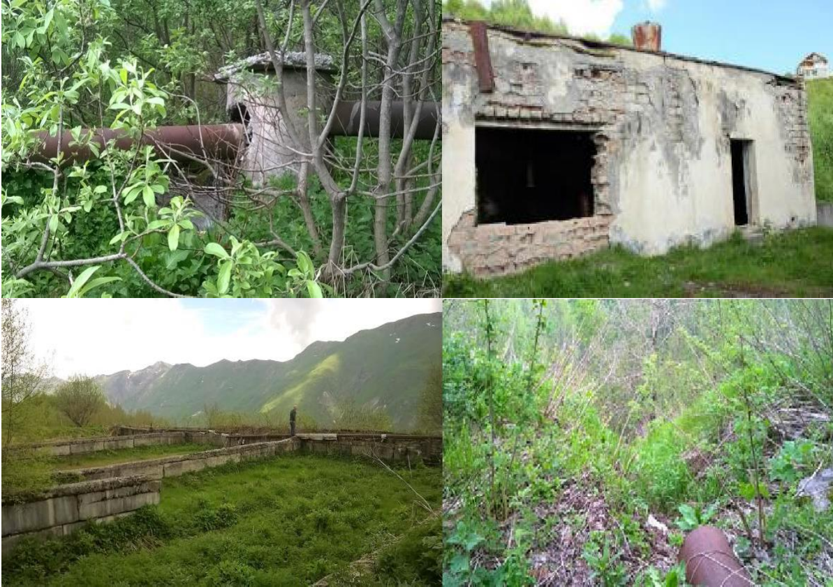
სურ. N 5 ძველი კოლექტორი, წყალგამყვანი მილი და დანგრეული, ძველი ჩამდინარე წყლების გამწმენდი ნაგებობა გუდაურში (N 2 გამწმენდის საპოექტო ტერიტორია).
