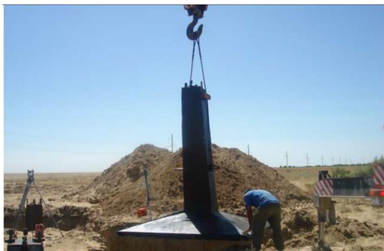
ნახ. 3.5.5 წინასწარ ჩამოსხმული რკინაბეტონის საძირკვლის მონტაჟის პროცესი
