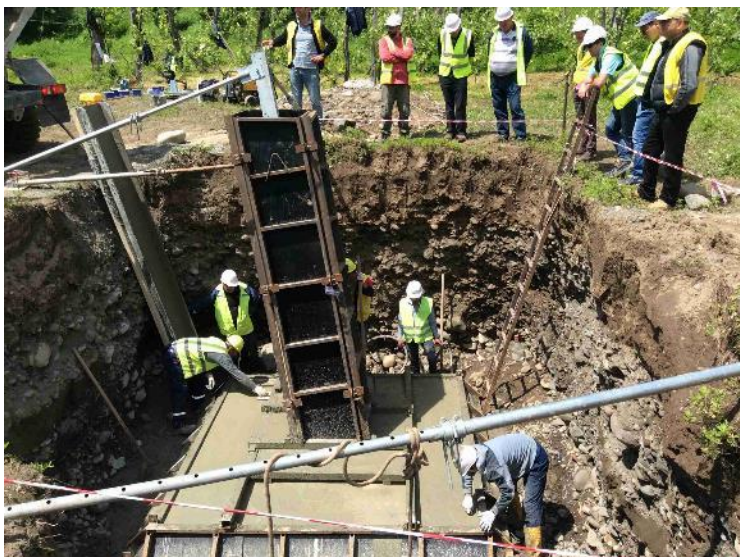
ნახ. 3.5.6 საძირკვლების დამონტაჟება ყალიბის კონსტრუქციის გამოყენებით, ანბა #264
