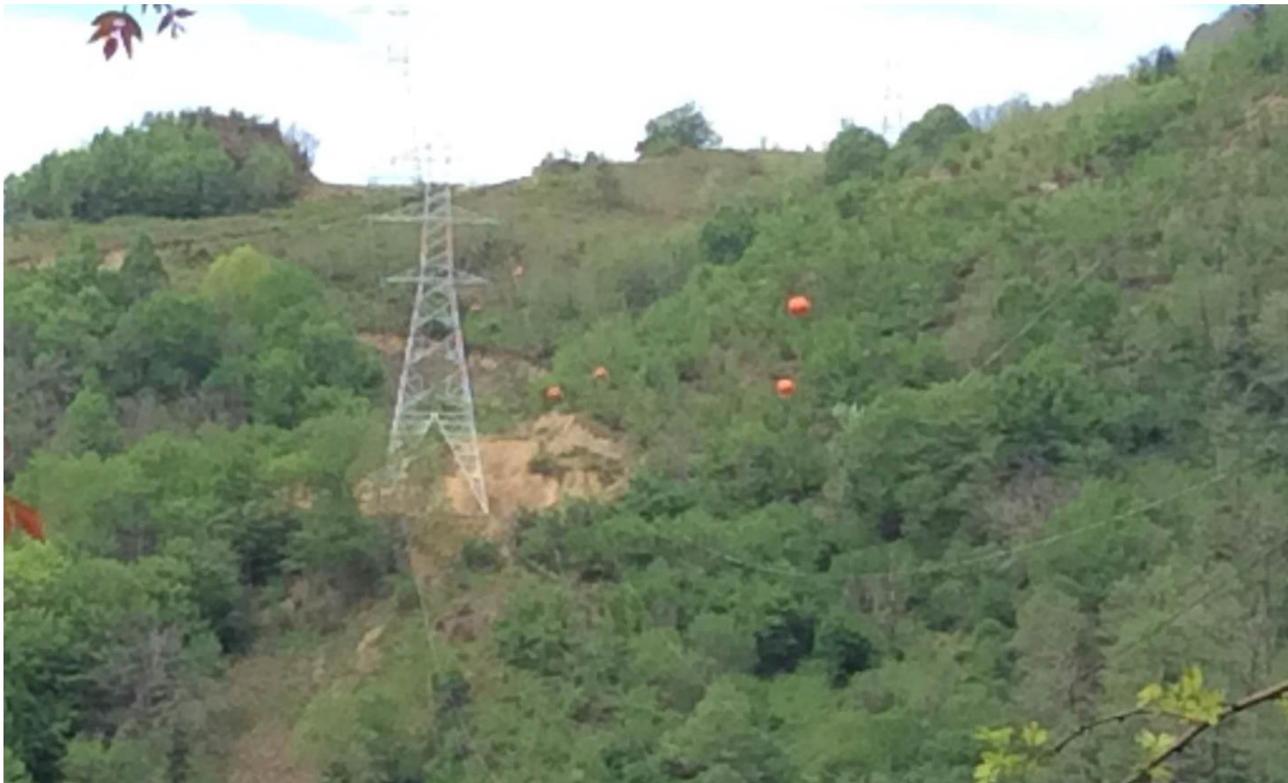
ნახ. 10.4.10 #367-365 ანძებზე დამონტაჟებული მიმმართველები
