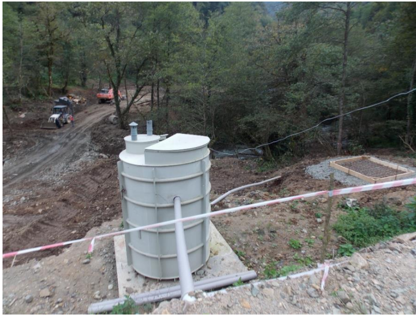
სურათი 3.1.1. სამშენებლო ბანაკზე დამონტაჟებული გამწმენდი დანადგარის ხედი
