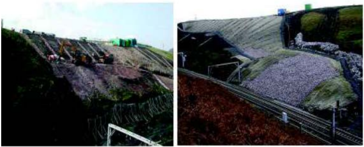
სურათი 7.4.2. მდგრად ფერდობზე გრუნტის აქტიური სტაბილიზირების და გამაგრების ღონისძიებების მაგალითები
