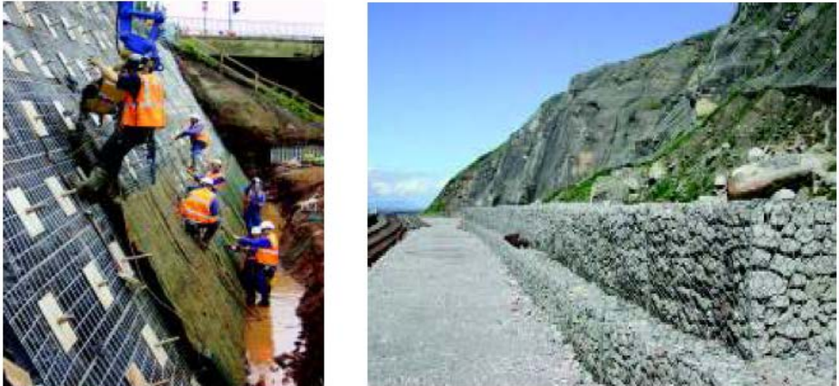
სურათი 7.4.2. მდგრად ფერდობზე გრუნტის აქტიური სტაბილიზირების და გამაგრების ღონისძიებების მაგალითები
