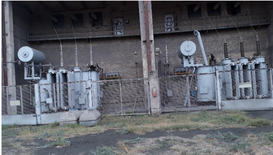
რუსთავის ცემენტის ქარხნის ქვესადგურის ორ ტრანსფორმატორიანი (25 მვა და 16 მვა) ღია გამანაწილებელი მოწყობილობა
