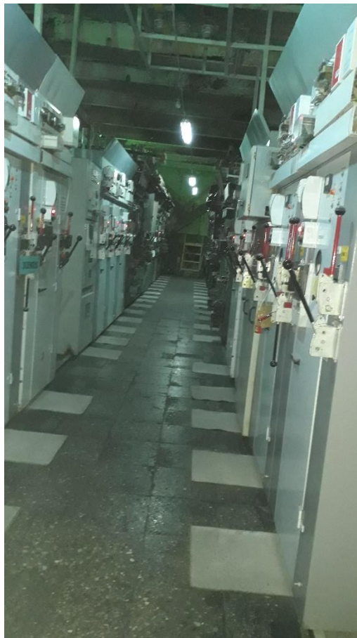
რუსთავის ცემენტის ქარხნის ქვესადგურის ნკვ დახურული გამანაწილებელი მოწყობილობა
