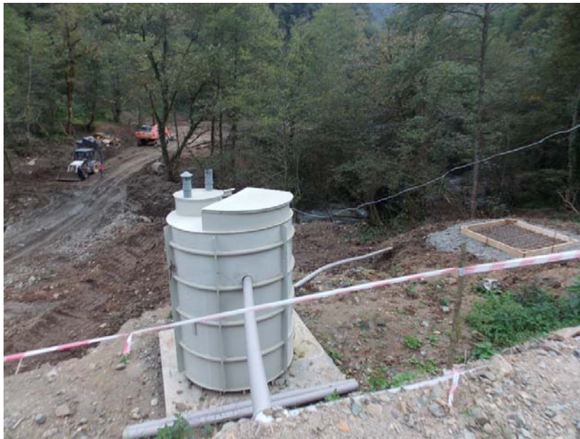
სურათი 4.1.1. სამშენებლო ბანაკზე დამონტაჟებული გამწმენდი დანადგარი
