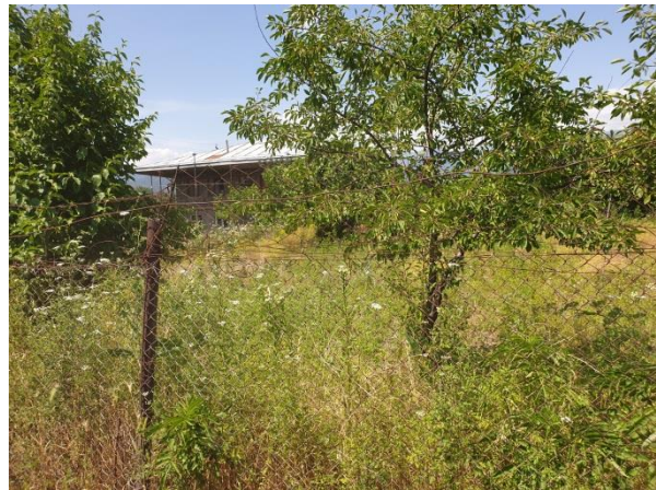
საცხოვრებელი სახლი სოფ ნაფარეულის ტერიტორიაზე. დაშორება - 25 მ
