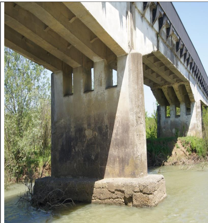
სურ 2 არსებლ ხიდზე დაფიქსირებული დაზიანებები
