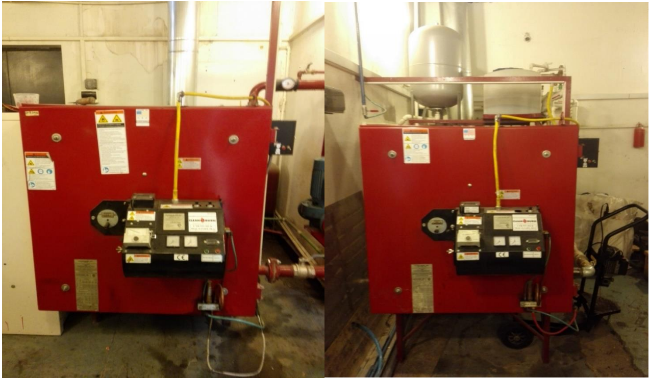
სურ.№3 - ობიექტზე განთავსებული „CLEAR BURN“-ის მოდელის წყალგამათბობელი
