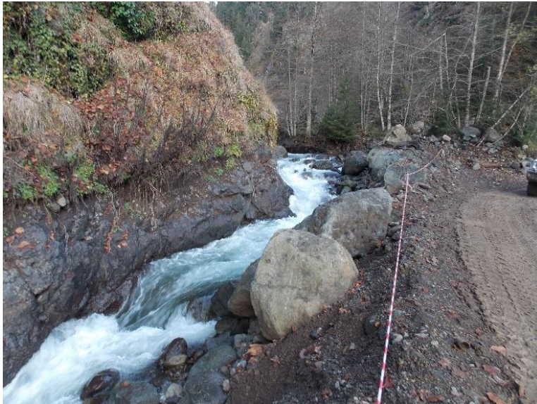
სურათი 3.4.4.1. კასლეთი 2 ჰესის სათავე ნაგებობაზე მიმდინარე სამუშაოებისას გამოყენებული დროებითი სადერივაციო არხი
