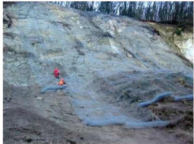
სურათი 5.4.3.2. ქვათაცვენის პრევენციული ღონისძიებების მაგალითი
