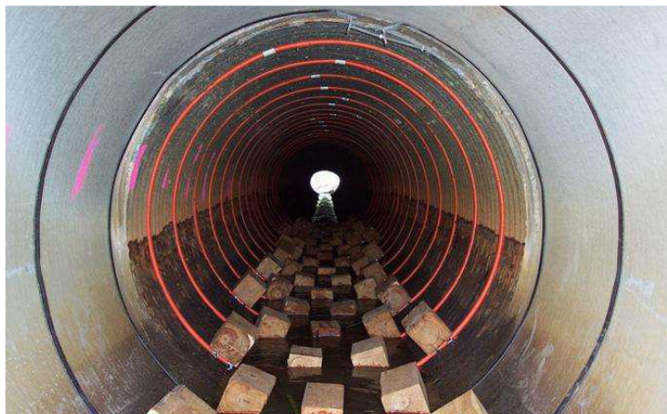
სურათი 3.4.4.3. თევზსავალი მილებიან კულვერტებში
