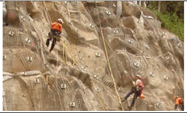
წყარო: Specialised Geo
