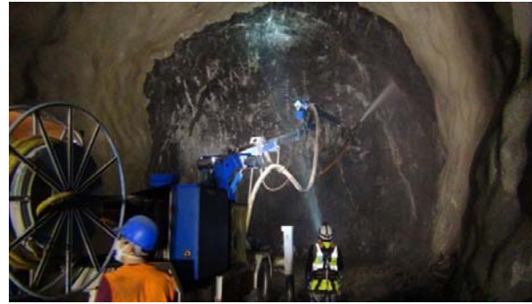
სურათი 3.1.5. ტორკრეტბეტონის მისხურება საბოლოო გამაგრებისთვის
