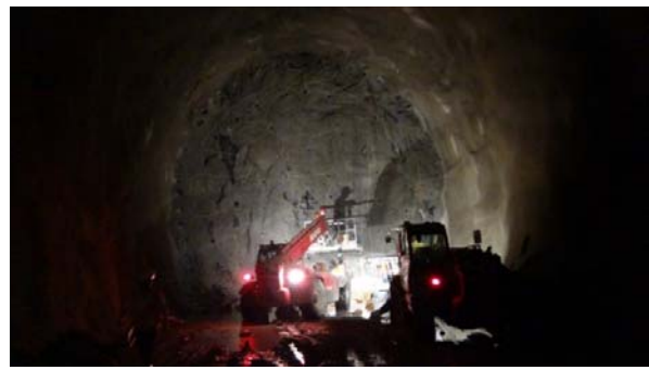
სურათი 3.1.3. ასაფეთქებელი მასალის შპურებში განთავსება
