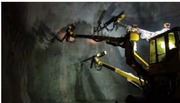
სურათი 3.1.2. ბურღვა საბურღი ურიკის გამოყენებით
