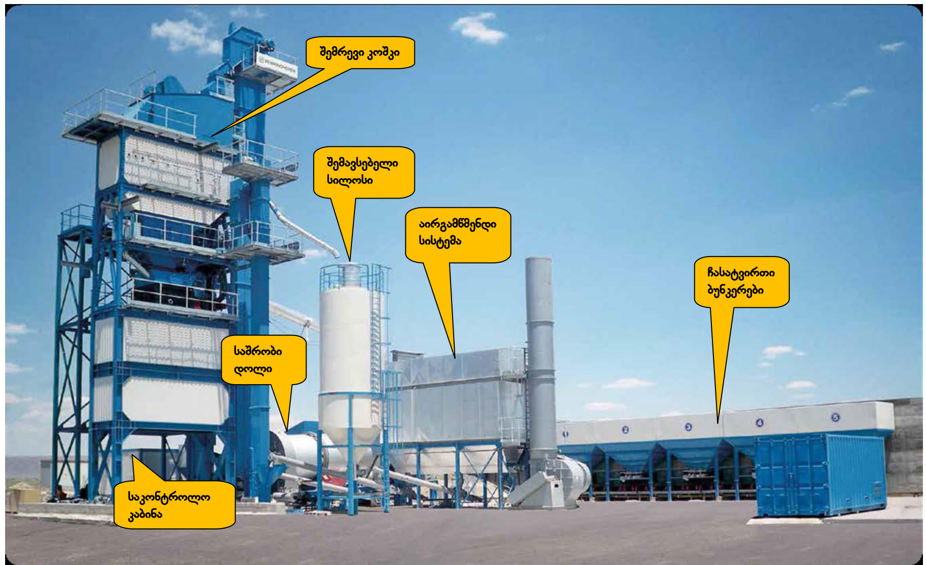
სურათი 2.2.1.2. კონტეინერული ტიპის ასფალტემრევი ქარხნის BENNINGHOVEN, ECO-4000-ის საერთო ხედი
