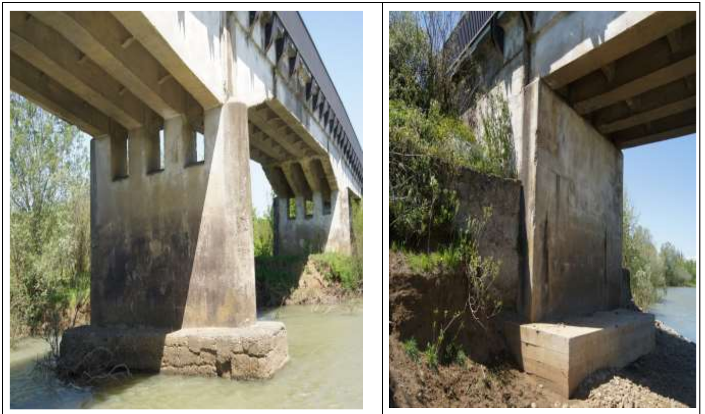
სურ 2 არსებლ ხიდზე დაფიქსირებული დაზიანებები
