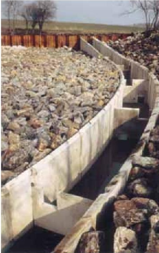
სურათი 2.2.2.1. შავი არაგვი ჰესზე გათვალისწინებული თევზსავალის ტიპური კონსტრუქცია
