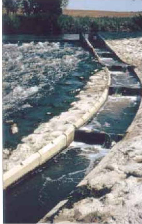
სურათი 2.2.2.1. შავი არაგვი ჰესზე გათვალისწინებული თევზსავალის ტიპური კონსტრუქცია
