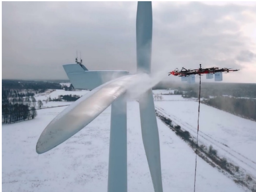
სურათი 6-12 დრონის გამოყენება ქარის ტურბინის გასაწმენდად
