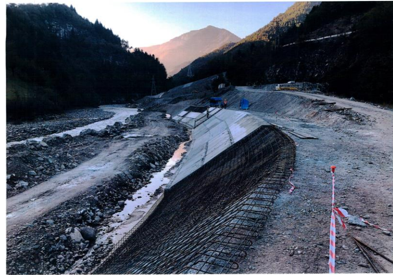
მდინარის მარჯვენა სანაპიროს ნაპირსამაგრის სამშენებლო სამუშაოები
