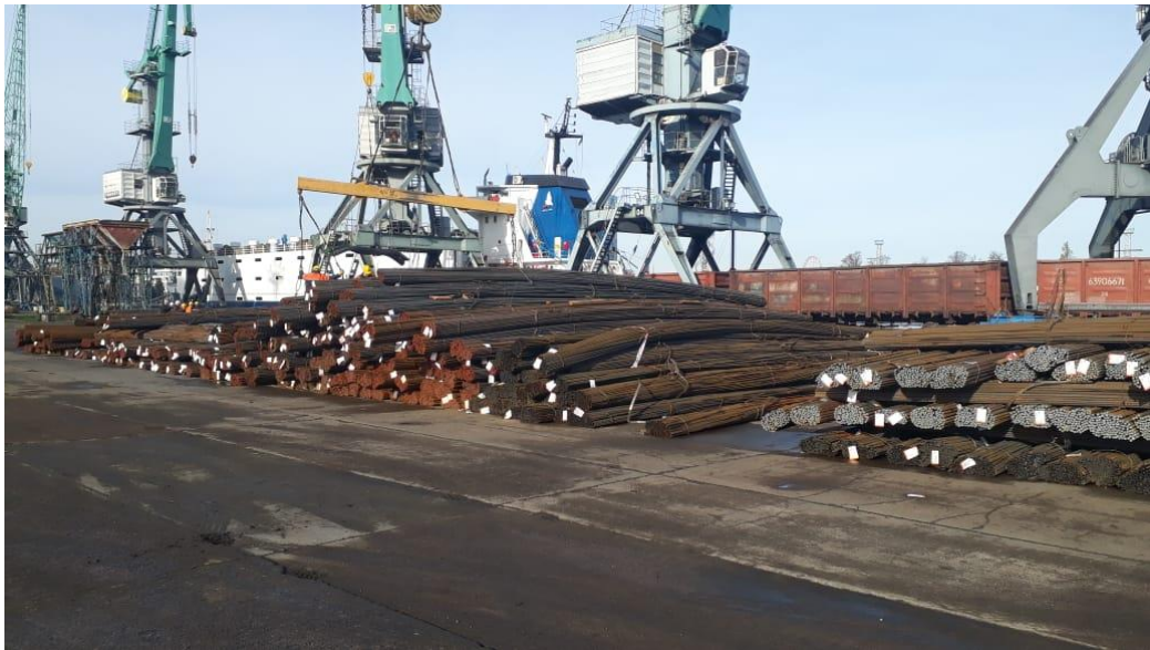
სურათი 2.3.2.1. ფოლადის არმატურის და ნამზადის ჩამოტვირთვის და დასაწყობების მეთოდები
