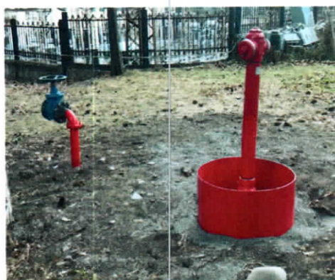
სურათი 9. სახანძრო ავზი, მილსადენი და ჰიდრანტი
