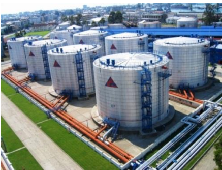
ნახაზი 3.3.1.3. №№224 ÷238 რეზერვუარების პარკი ძირითად ტერიტორიაზე
