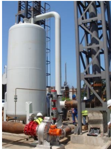
სურათი 3.4.3.2. აირგამწმენდი ფილტრი „ნედი ნავთობისა და მაზუთის“ უბანში
