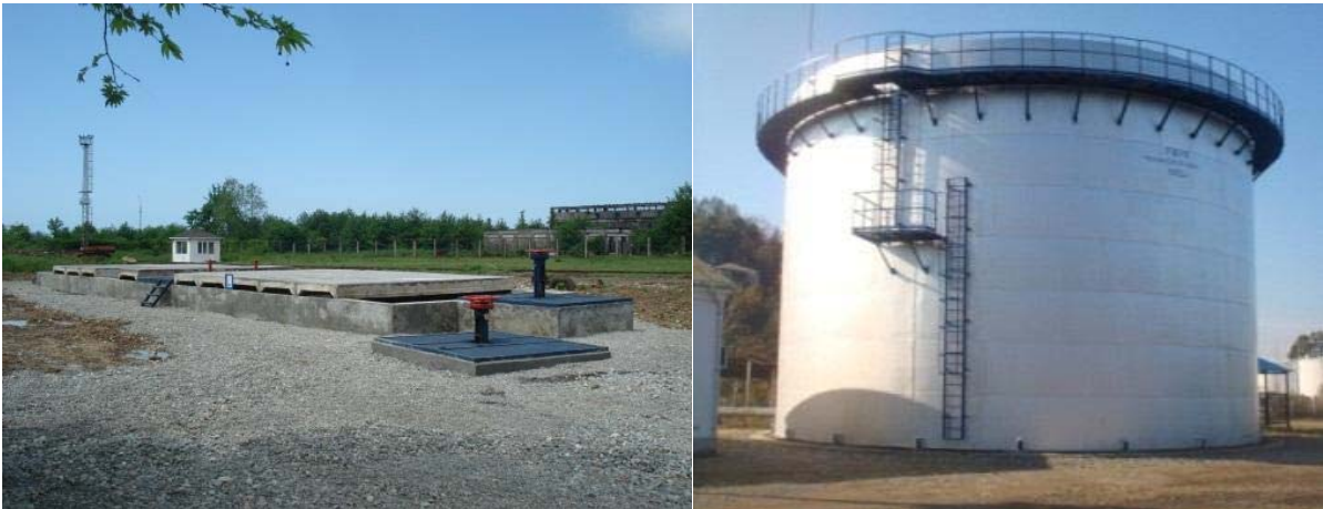
სურათი 5. გნა-ს მიღების და გადატვირთვის სადგურის არსებული ნავთობდამჭერი და 3000 მ 3 ტევადობის სახანძრო რეზერვუარი
