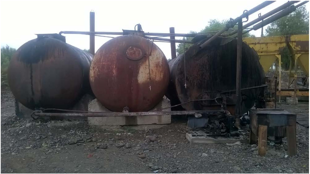
სურათი № 3.1.1. ბიტუმის გამაცხელებელი სანთურები გაფრქვევის მილით
