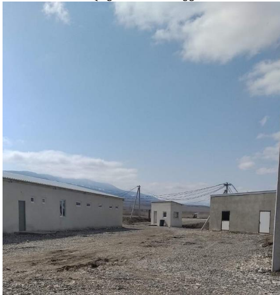
სასაკლავოს ტერიტორიაზე მოწყობილი ინფრასტრუქტურა
