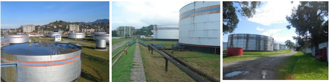
ნახაზი 3.3.4.1. ხალოდნაია სლობოდას რეზერვუარები
