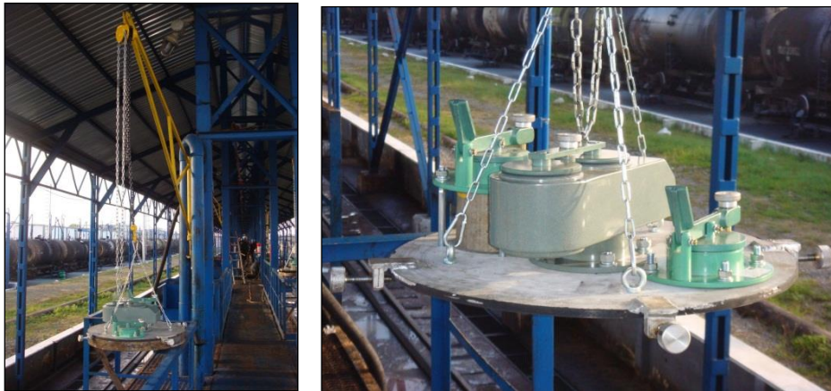
სურათი 3.4.1.1. ჰერმეტიზაციის სარქველები № 5 სარკინიგზო ესტაკადაზე
