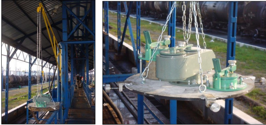
სურათი 3.2.1. 5. ჰერმეტიზაციის სარქველები № 5 სარკინიგზო ესტაკადაზე
