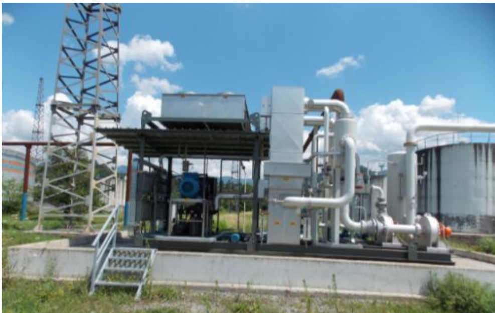
ნახაზი 3.4.5.1. ნავთობბაზის ნახშირწყალბადოვანი აირების სარეკუპერაციო დანადგარი
