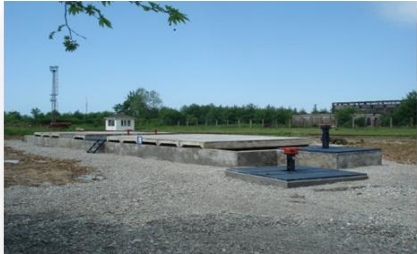
სურათი 3.2.1.4. გნა-ს მიღების და გადატვირთვის სადგურის არსებული ნავთობდამჭერი და 3000 მ3 ტევადობის სახანძრო რეზერვუარი
