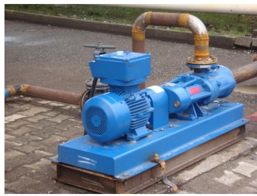
სურათი 5.1.6.9. ჩამდინარე წყლების მიმღები ჭები და გადასატუმბი დანადგარები №2 და №3 ნავმისადგომებზე
