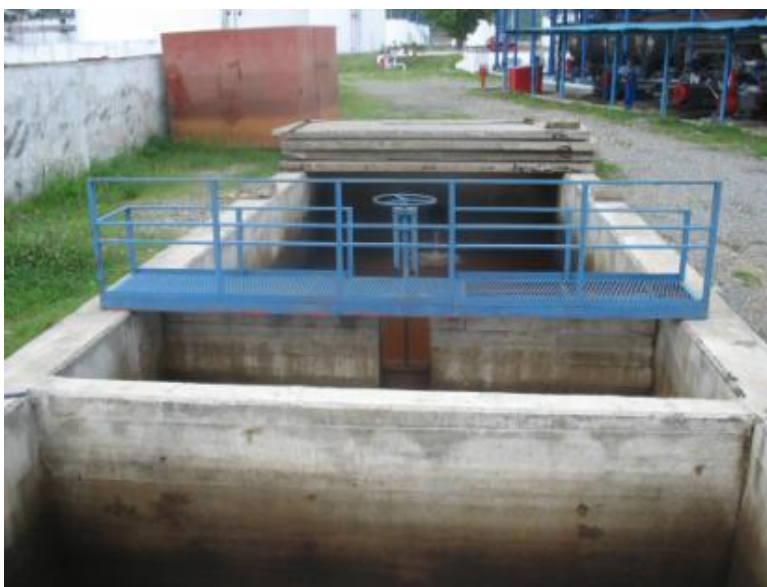
სურათი 5.6.3. ნავთობბაზის ლოკალური ნავთობდამჭერის ხედი
