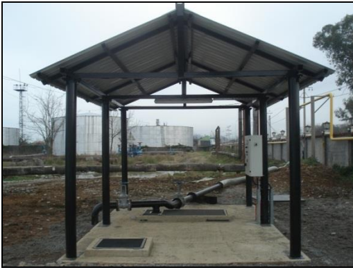
სურათი 5.5.3. ორი 20 000 მ 3 ტევადობის ნავთობის რეზერვუარების პარკის პირობითად სუფთა წვიმის წყლების გაყვანის სატუმბო სადგური და საწნეო მილსადენი
