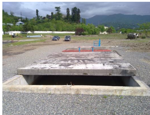
სურათი 5.2.3. „კაპრეშუმი“-ს უბნის №2 ნავთობდამჭერი (გეგმა)
