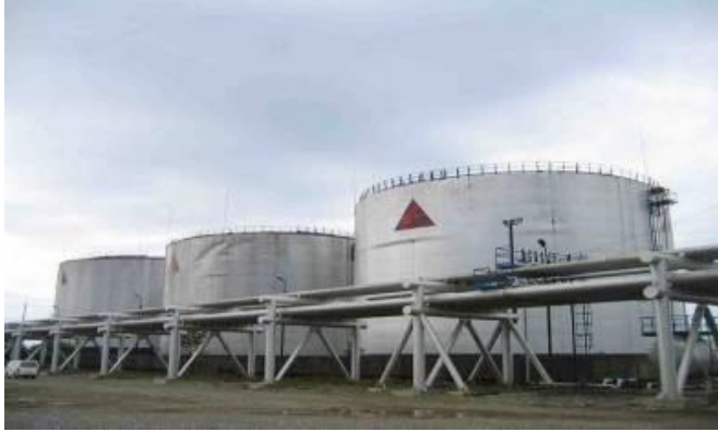
სურათი 5.1.6.3. ნავმისადგომების უბნის (ბალასტური და ლიალური წყლების) გამწმენდი ნაგებობების ბუფერული რეზერვუარები
