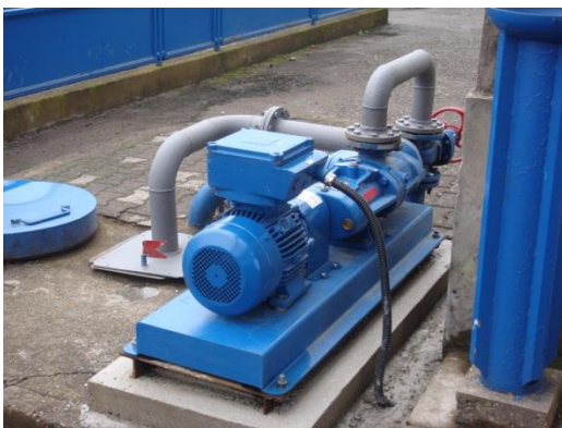
სურათი 5.1.6.9. ჩამდინარე წყლების მიმღები ჭები და გადასატუმბი დანადგარები №2 და №3 ნავმისადგომებზე
