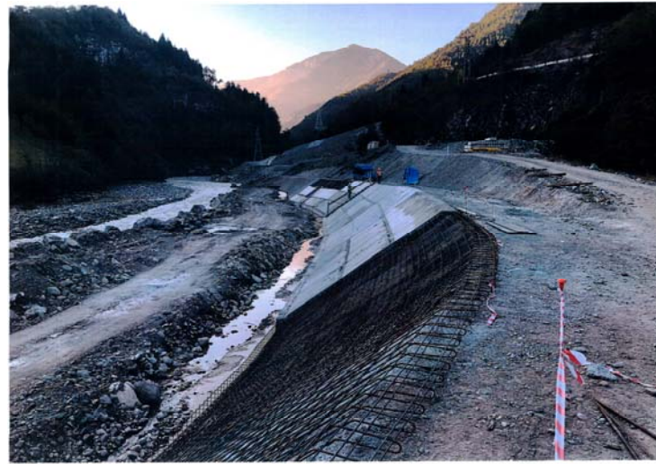
მდინარის მარჯვენა სანაპიროს ნაპირსამაგრის სამშენებლო სამუშაოები
