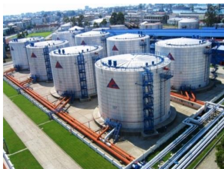
სურათი 3.2.3. №№224 ÷238 რეზერვუარების პარკი ძირითად ტერიტორიაზე
