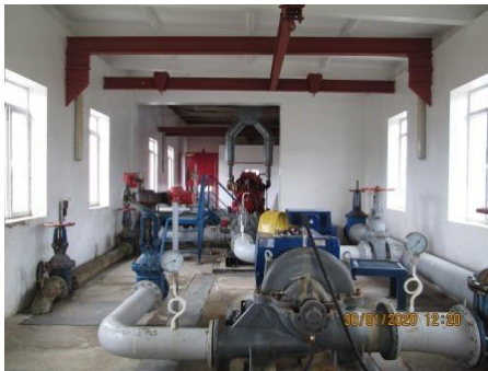
სურათი 3.16.1. სახანძრო წყლის მიწოდების სატუმბო სადგურები ძირითად ტერიტორიაზე და ხოლოდნაია სლობოდას უბანზე
