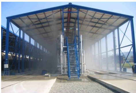
სურათი 3.16.3. ხანძარქრობის ქაფის ხსნარის მიწოდების სისტემები N2 სარკინიგზო ესტაკადაზე და სარეზერვუარო პარკში
