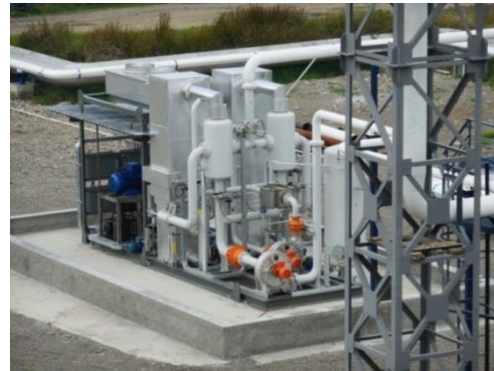
სურათი 3.16.2.6. აირგამწმენდი (აირების რეკუპერაციის) დანადგარი ნავთის უბანში
