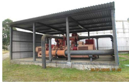
სურათი 3.16.1. სახანძრო წყლის მიწოდების სატუმბო სადგურები ძირითად ტერიტორიაზე და ხოლოდნაია სლობოდას უბანზე
