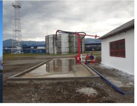
სურათი 3.3.4. ავტოცისტერნებში დიზელის საწვავის ჩასასხმელი დგარი
