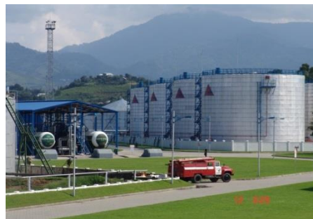
სურათი 3.16.3. ხანძარქრობის ქაფის ხსნარის მიწოდების სისტემები N2 სარკინიგზო ესტაკადაზე და სარეზერვუარო პარკში
