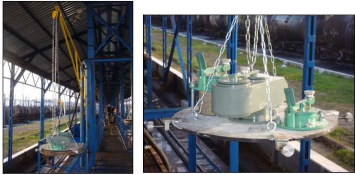
სურათი 3.16.2.1. ჰერმეტიზაციის სარქველები № 5 სარკინიგზო ესტაკადაზე
