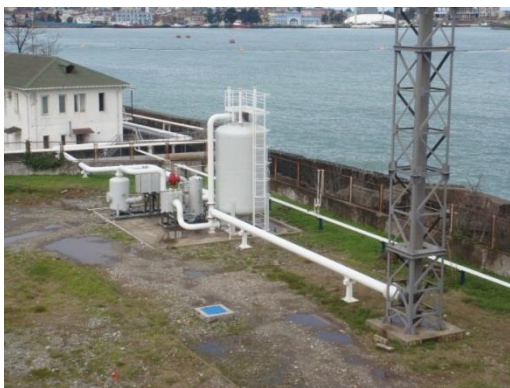
სურათი 3.4.2.1. აირგამწმენდი დანადგარი ნავმისადგომის უბანზე და უნაპირო ნავმისადგომიდან გაფრქვეული აირების გამყვანი მოტივტივე შლანგი
