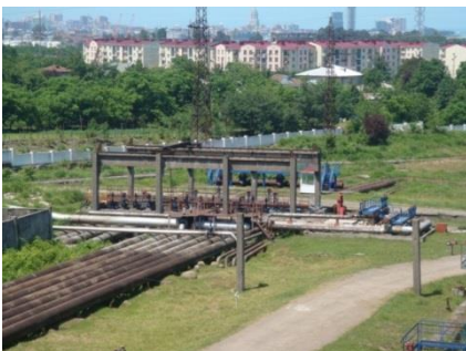
ნახაზი 3.3.5.2. ნედლი ნავთობის მიღების და გადატვირთვის სადგური - „კაპრემუმის“ ტექნოლოგიური მილსადენები, მთავარი მანიფოლდი, და სატუმბო სადგურის შენობა
