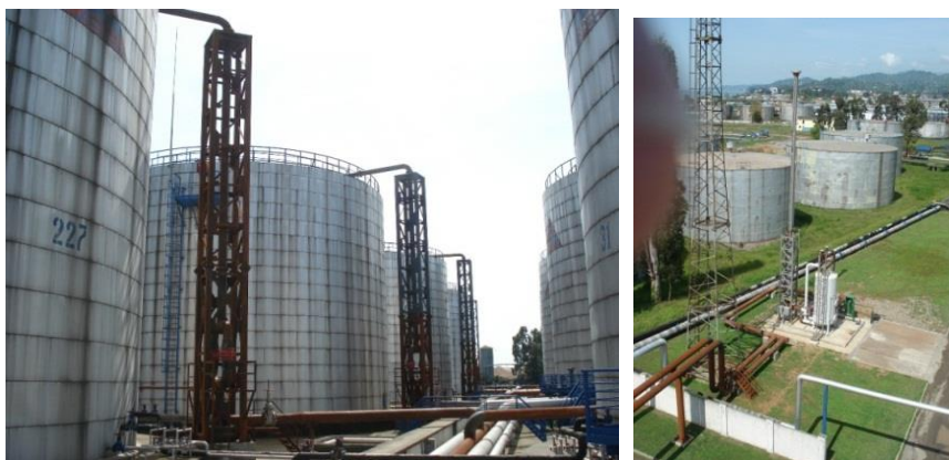
სურათი 3.4..3.1. №№ 224, 225, 226, 227, 228, 229,230, 231, 236, 237 და 238 რეზერვუარების აირგამათანაბრებელი სისტემის და აირგამწმენდი ფილტრის საერთო ხედები
