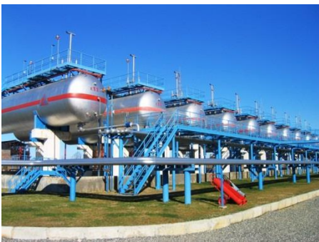
სურათი 3.2.2.3 გნა-ს მიღების და გადატვირთვის სადგურის არსებული რეზერვუარების პარკი და დემონტაჟს დაქვემდებარებული სარკინიგზო ესტაკადა
