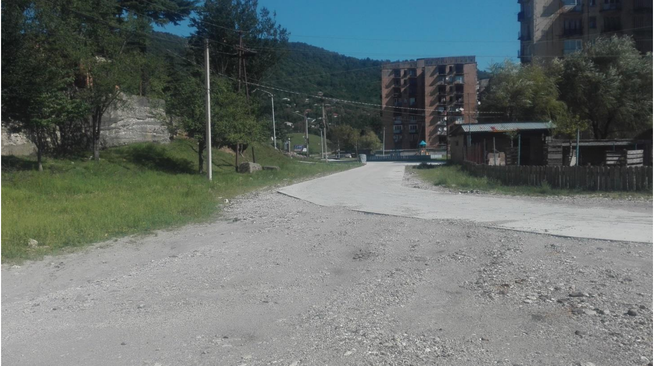
სურათი 8. მისასვლელი გზის მობეტონებული უბანი.
