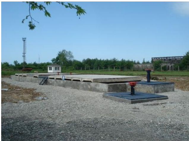
სურათი 5. გნა-ს მიღების და გადატვირთვის სადგურის არსებული ნავთობდამჭერი და 3000 მ 3 ტევადობის სახანძრო რეზერვუარი
