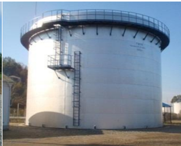
სურათი 5. გნა-ს მიღების და გადატვირთვის სადგურის არსებული ნავთობდამჭერი და 3000 მ 3 ტევადობის სახანძრო რეზერვუარი
