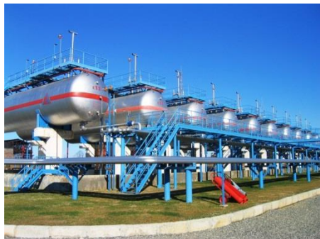
სურათი 3.1.1.2. გნა-ს მიღების და გადატვირთვის სადგურის არსებული რეზერვუარების პარკი და სარკინიგზო ესტაკადა
