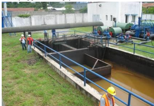
ნახაზი 5.6.1.4. ოთხკამერტიანი ნავთობდამჭერი N2 (ხედი)
