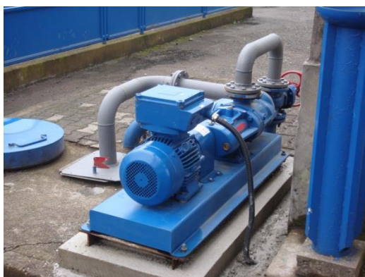
სურათი 5.1.5.9. ჩამდინარე წყლების მიმღები ჭები და გადასატუმბი დანადგარები №2 და №3 ნავმისადგომებზე
