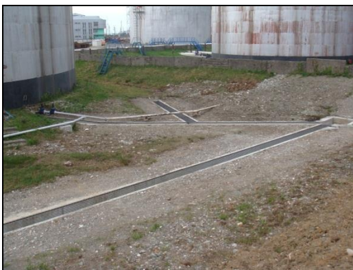
ნახაზი 5.1.1.2. ნავთის უბნის №№161, 162, 163, 164 რეზერვუარების პარკის საწარმოო-სანიაღვრო კანალიზაციის სისტემა
