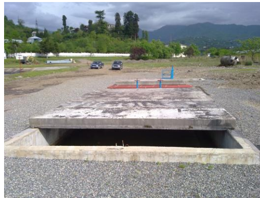
სურათი 5.2.3. „კაპრეშუმი“-ს უბნის №2 ნავთობდამჭერი (გეგმა)
