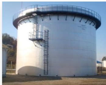
სურათი 3.1.1.4. გნა-ს მიღების და გადატვირთვის სადგურის არსებული ნავთობდამჭერი და 3000 მ3 ტევადობის სახანძრო რეზერვუარი
