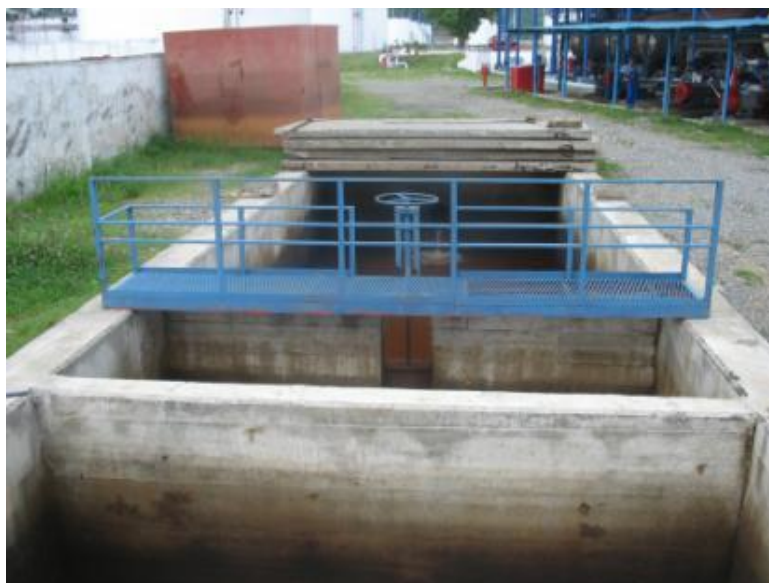
სურათი 5.6.3. ნავთობბაზის ლოკალური ნავთობდამჭერის ხედი
