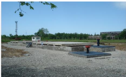
სურათი 3.1.1.4. გნა-ს მიღების და გადატვირთვის სადგურის არსებული ნავთობდამჭერი და 3000 მ3 ტევადობის სახანძრო რეზერვუარი
