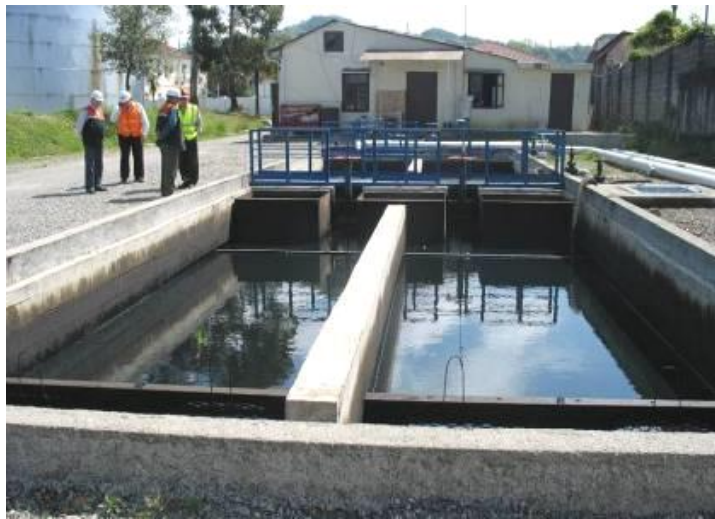
სურათი 5.1.2.2. დიზელის უბნის ნავთობდამჭერი
