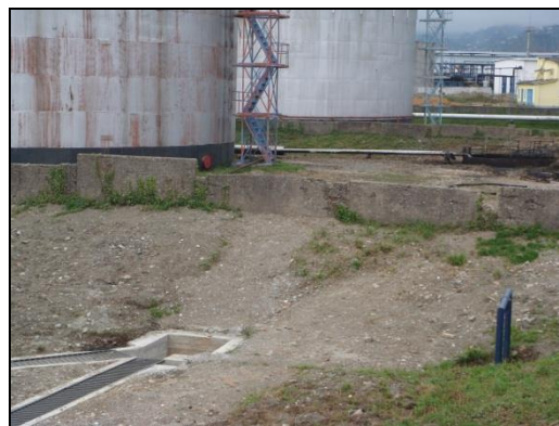
ნახაზი 5.1.1.2. ნავთის უბნის №№161, 162, 163, 164 რეზერვუარების პარკის საწარმოო-სანიაღვრო კანალიზაციის სისტემა
