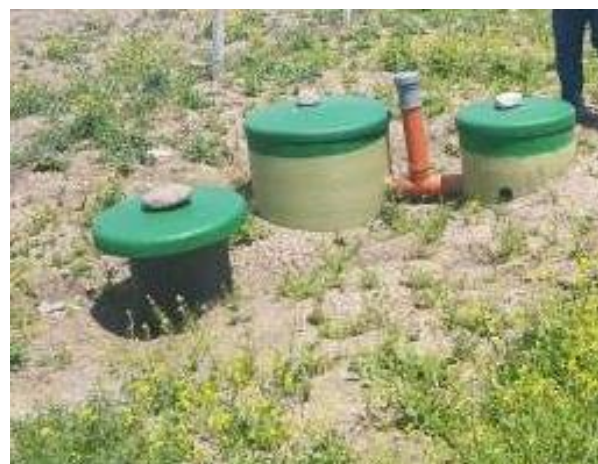
ფრინველთა სასაკალოს ტერიტორიაზე მოწყობილი სამეურნეო-საყოფაცხოვრებო წყლების გამწმენი ნაგებობა
