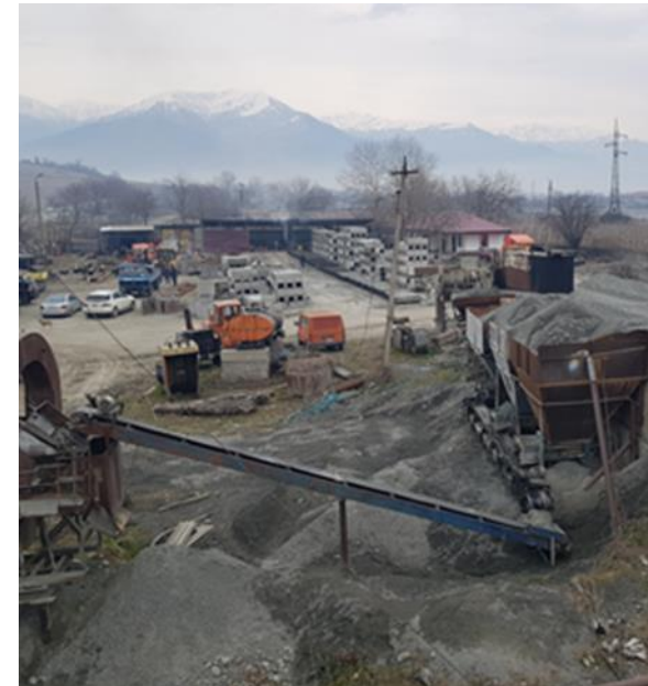
საწარმოს ტერიტორიის ზოგადი ხედი
