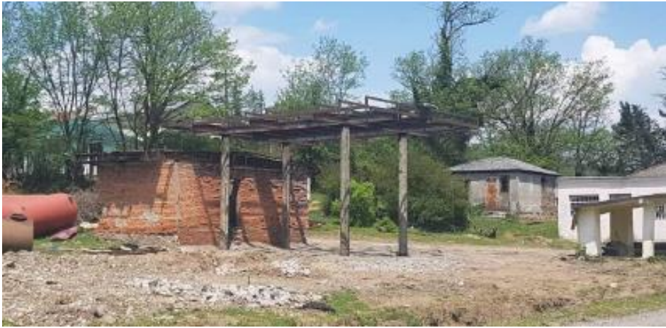
სურათი N10 საპროექტო ტერიტორია მშენებლობის დაწყებამდე
