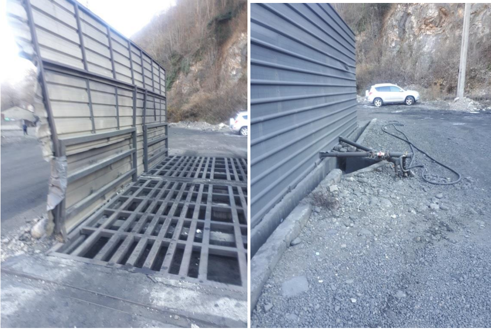
სურათი 9.6. შპს „მგტ“-ს მიმდებარედ არსებული მანქანების ძარისა და საბურავების კერძო საერთო სამრეცხაო
