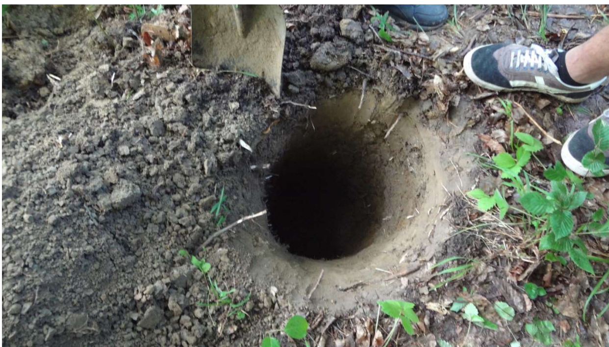
სურათი #24. #24 შურფბურღილის გაყვანის პროცესი. ლითოლოგიურად 1.5 მ სიღრმიდან წარმოდგენილი ნახევრად კლდოვანი ძირითადი ქანით - არგილითით. მორფოლოგიურად ის განთავსდება ფერდობის ძირში, თხრილთან – საავტომობილო გზის მომიჯნავედ.
