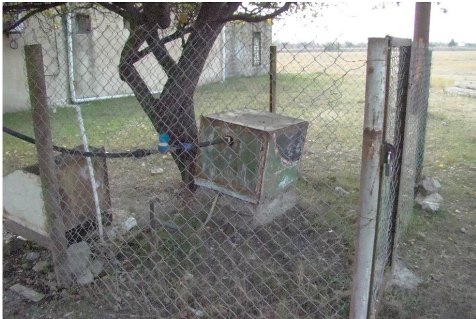
სურ. N 13 - ობიექტის ტერიტორიაზე არსებული მიწისქვეშა წყლის ჭაბურღილი
