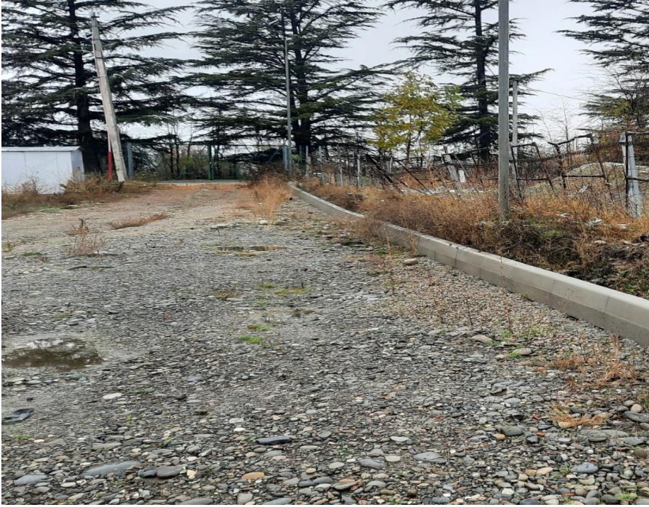
სურათი N6. ტერიტორიაზე შემოსასვლელი გზა.
