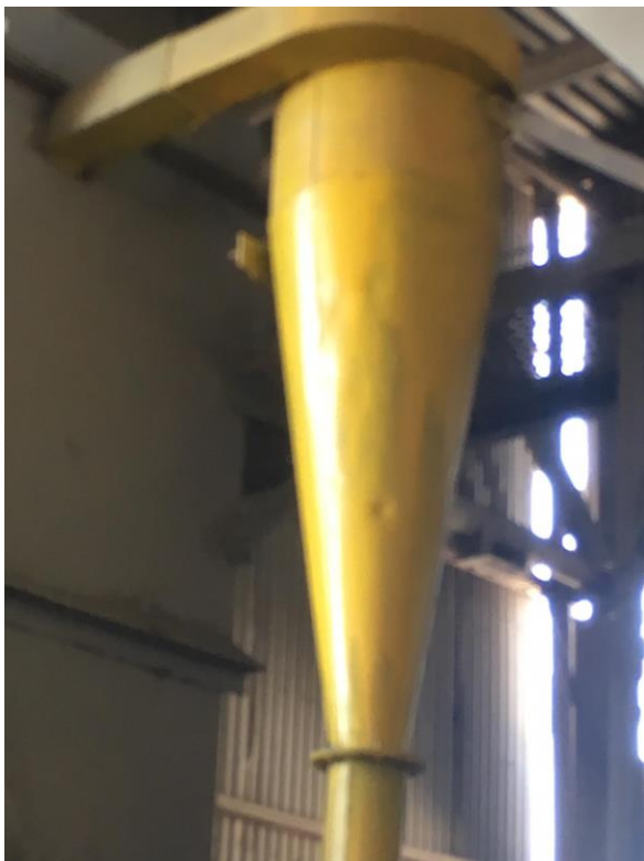
დამონტაჟებული ციკლონები. სურათი 7.3.
