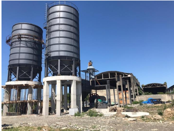
სურათი 3.4.7. ცემენტის სილოსები, ნახევრად აშენებულ მდგომარეობაში
