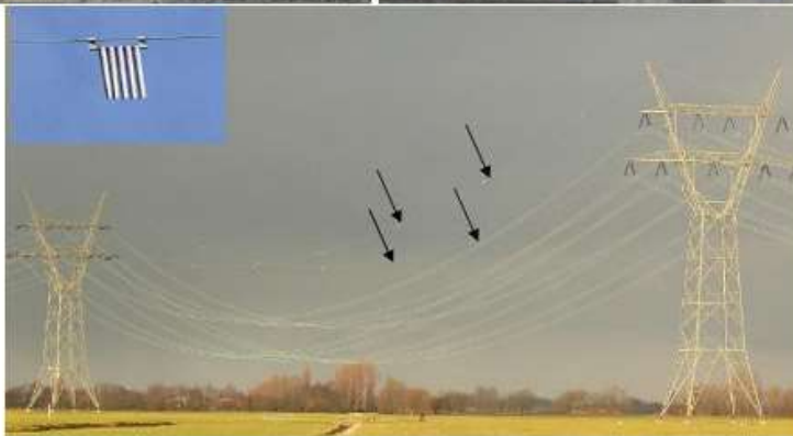
სურ. 6.9.4.1. ეგზ-ების სადენებზე გამოყენებული მარკირების მაგალითები
