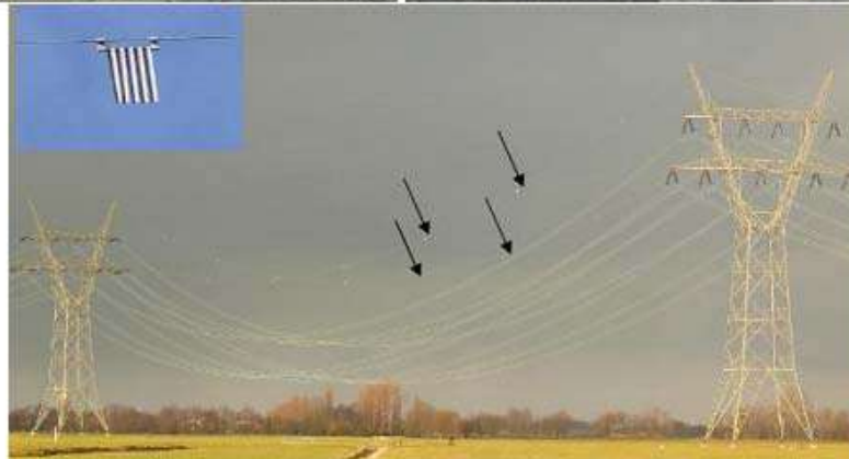
სურ. 6.9.4.1. ეგზ-ების სადენებზე გამოყენებული მარკირების მაგალითები
