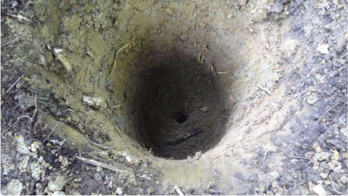
სურათი #27. #27 შურფბურღილის გაყვანის პროცესი. ლითოლოგიურად წარმოდგენილი მოყავისფრო-მოყვითალო ძნელპლასტიკური თიხებით. ადგილის რელიეფი წარმოადგენს აღმოსავლეთიდან დასავლეთით 10-15°-ით დახრილ ფერდობს ფართოფოთლოვანი ტყის საფარით.
