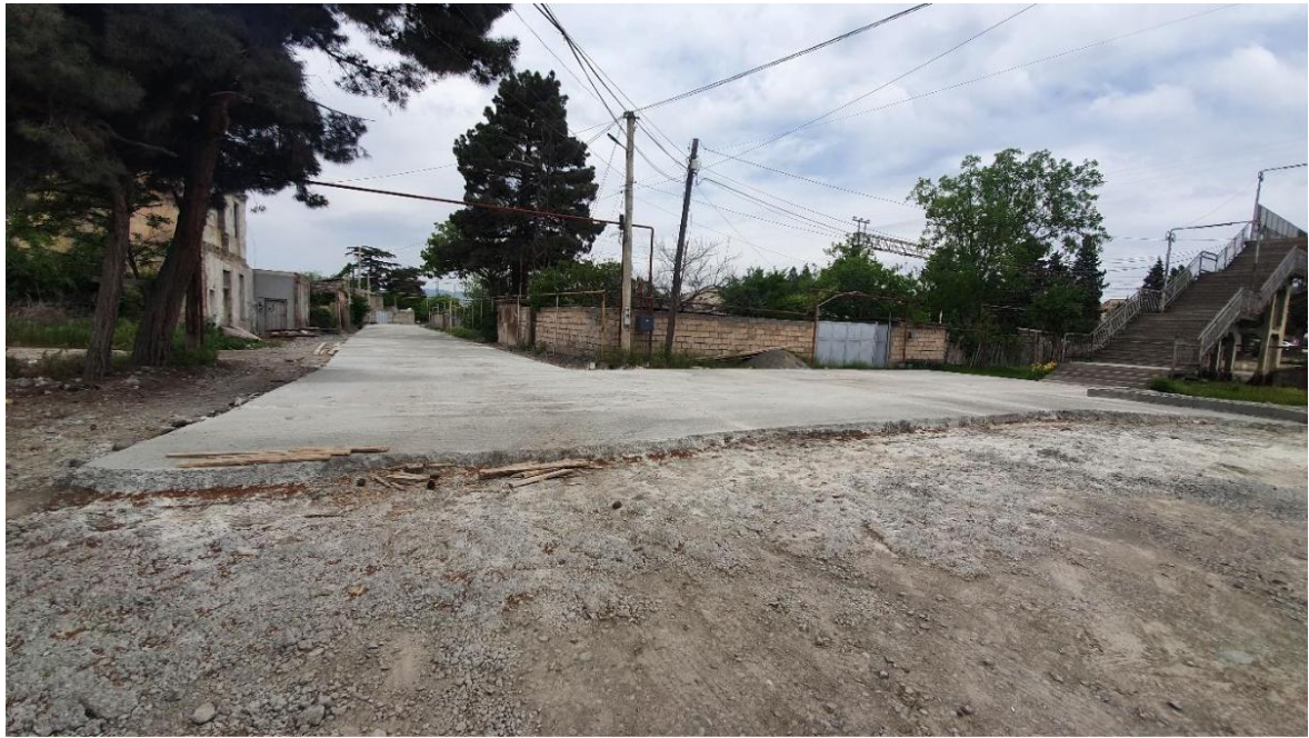
სურათი 1. ფარნავაზის ქუჩის ბეტონის საფარით რეაბილიტირებული გზის ნაწილი.
