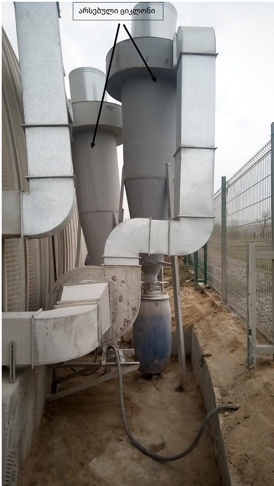
სურათი2. მშრალი ნარევების საამქროს ასპირაციული სისტემის არსებული ციკლონები
