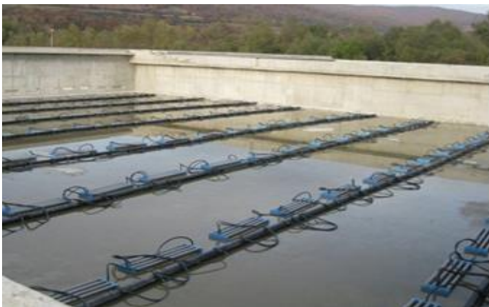
სურ. 6.3 - მარცხენა: აშენებული აუზის ნიმუში დიფუზორის სისტემით. მარჯვენა - აერატორი სარემონტო მდგომარეობაში (ნიმუში)
