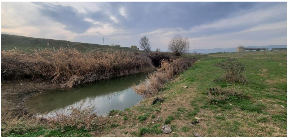
სურ 16.1 - საპროექტო ტერიტორიის მიმდებარედ არსებული ჩაღრმავება
