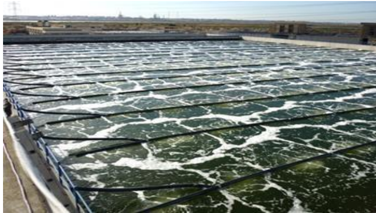
სურ. 9 - მარცხენა: ამენებული აუზი დიფუზორის სისტემით. მარჯვენა: აერატორი სარემონტო მდგომარეობაში (ნიმუში)
