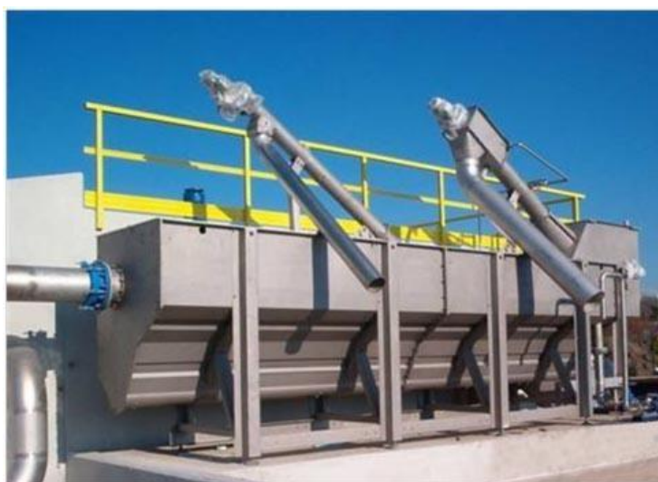
სურ. 7 - ტიპური კომბინირებული ცხაურის/ქვიშა/ცხიმის მოცილება
