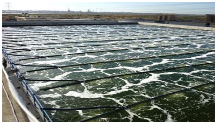
სურ. 3.1.4 - მარცხენა: აშენებული აუზი დიფუზორის სისტემით. მარჯვენა: აერატორი სარემონტო მდგომარეობაში (ნიმუში)
